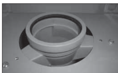
Připojovací místo pro odkouření u nových kondenzačních kotlů řad CERAPUR...
